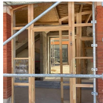
Réunion de chantier sur la pose des menuiseries extérieures et la problématique des briques déjà en place
